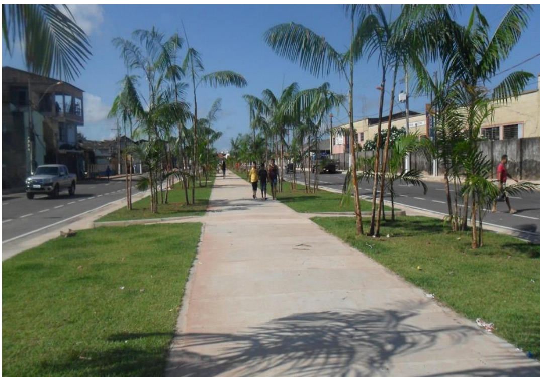
Figura 06 Trecho concluído (com aduelas) na Avenida Bernardo Sayão com vias asfaltadas, calçamento, ciclofaixa e área de estacionamento
